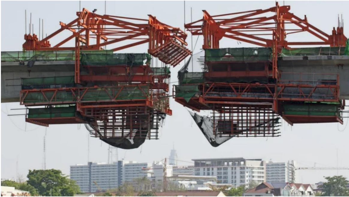
รูปที่ 8-10 ตัวอย่างการก่อสร้างชิ้นส่วนสะพานขั้นสุดท้ายกลางแม่น้ำ
