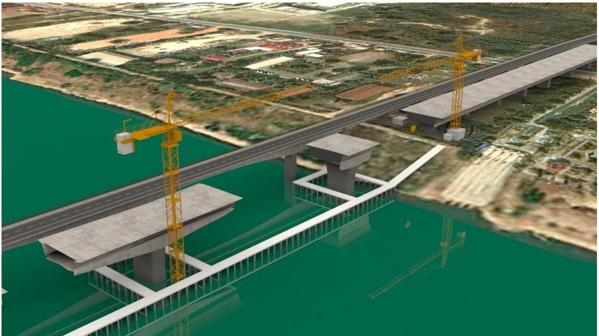
รูปที่ 8-8 งานก่อสร้างสะพานรถไฟช่วงกลางแม่น้ำโขง (ต่อ)
